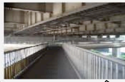
④歩道橋 横断歩道がない 上は高速道路
