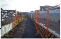
②狭い道 工事中で歩道が整備さ れていない
