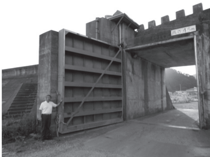
図表8 田老堤防の水門（撮影：関西大学社会安全学部消防・防災行政研究室）
