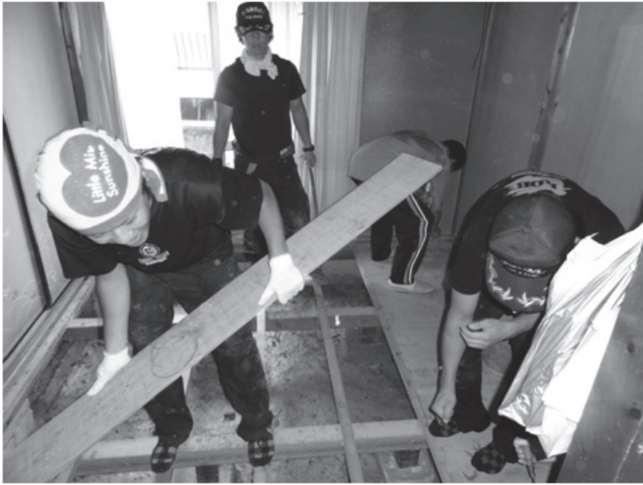
図表29 床下の泥を除去するため床を外す作業をする社会安全隊員 (撮影：社会安全隊)
