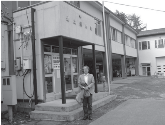
図表16 岩泉消防署（撮影：関西大学社会安全学部消防・防災行政研究室）
