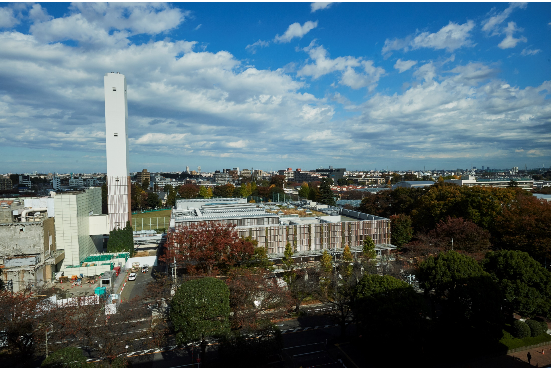
Musashino Clean Center 武蔵野クリーンセンター(東京都武蔵野市) (2017)
