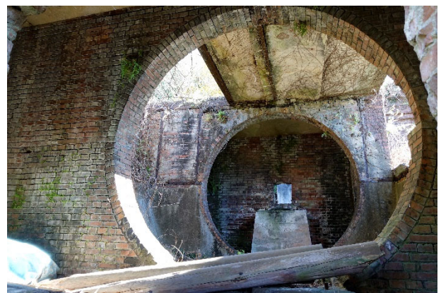
旧住吉一坑・扇風機上屋内部には、坑内空気を排気するための扇風機がはめ込まれていた円形台座が残る。老朽化が進行しており、事前許可を得て常磐炭鉱史研究会関係者同伴でなければ見学不可であるが、かつての鉱山技術の貴重な遺構であり、保存とさらなる利活用の両立が課題である。(2020年12月9日撮影)
