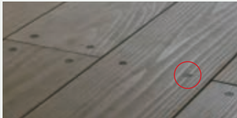
写真6 床材をビスで留めスギで栓をする
