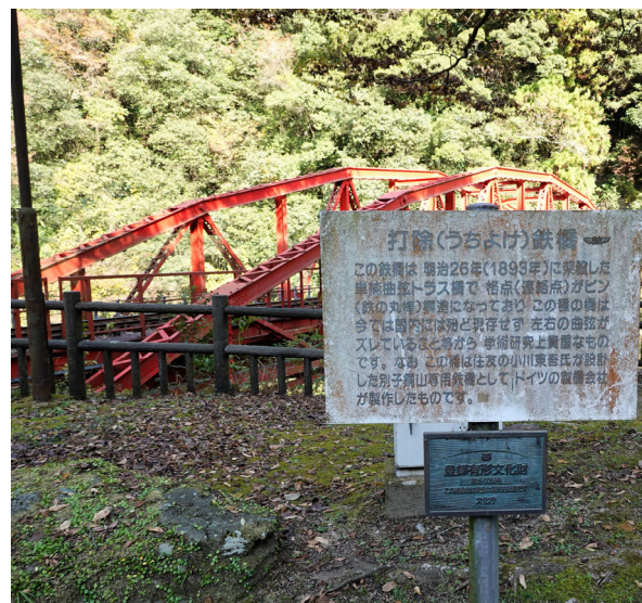
（図8）マイントピア別子・端出場ゾーン内にある旧別子銅山鉄道端出場鉄橋の解説板。同鉄橋は上述の通り銅山観光列車の路線として活用されているため、メンテナンスの必要がある。解説板の下に登録有形文化財であることを示す銅板プレートが取り付けられている。2021年11月撮影。
