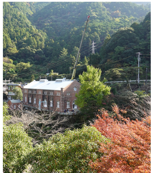
（図 6）旧端出場水力発電所（中央・煉瓦造の建物）をマイントピア別子から望む。耐震補強等工事による屋根の葺き替え中であり、架けられている波形鉄板は、既存（改修当時）の色合いに合わせられている。2021 年 11 月撮影。
